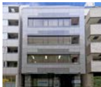
平河町昭和ビル
