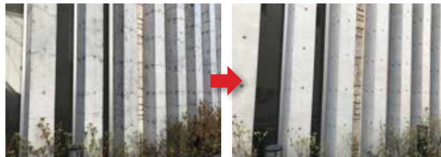
■柱廻り修繕工事（物件名：第3ケーユービル）
